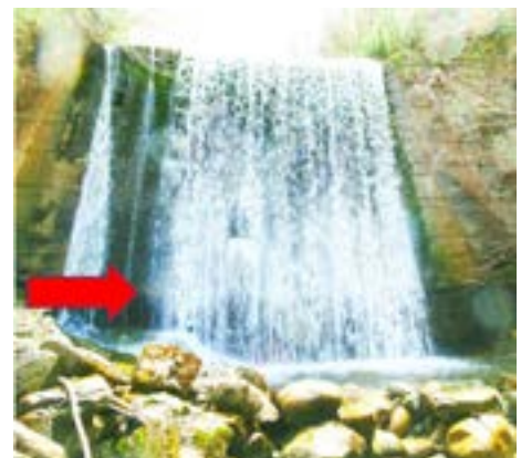
unterspülte Konsolidierungssperre
