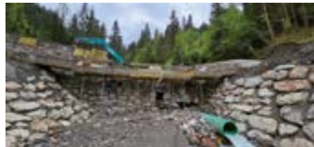
Sanierung der Steinsperre aus dem Jahr 1927
