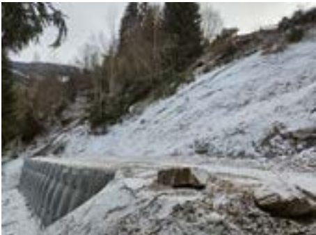
Ankerwand zur Wegsicherung im Bereich der Rutschung (Foto im Spätherbst)
